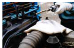
配管ロウ付作業・塩ビ管の取付作業。スパッタシートとの併用で一層効果的。
