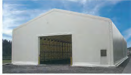
施工例：テント倉庫
