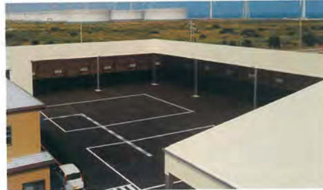
施工例：工場荷捌き場
