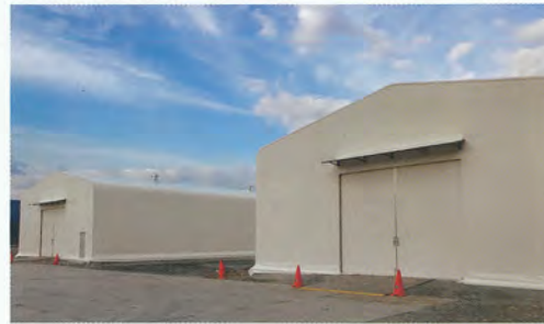
施工例：テント倉庫
