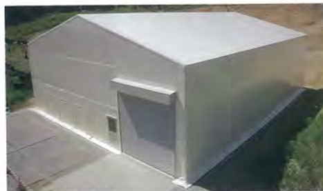
施工例：テント倉庫
