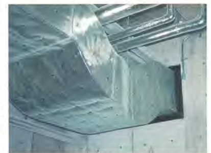
▲ ダクト遮音工事サンダムLA10
