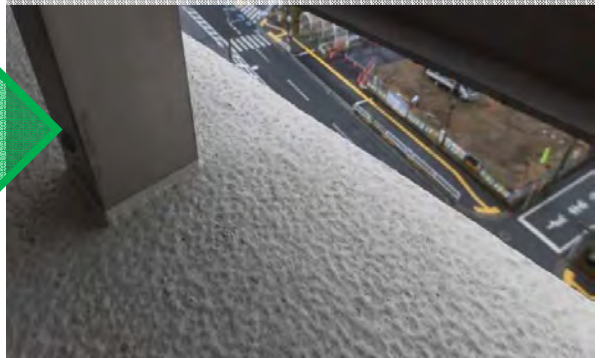
施工前に拭取り、乾燥させます
