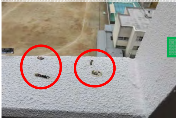
固定具設置箇所の汚れ(フンなど)
